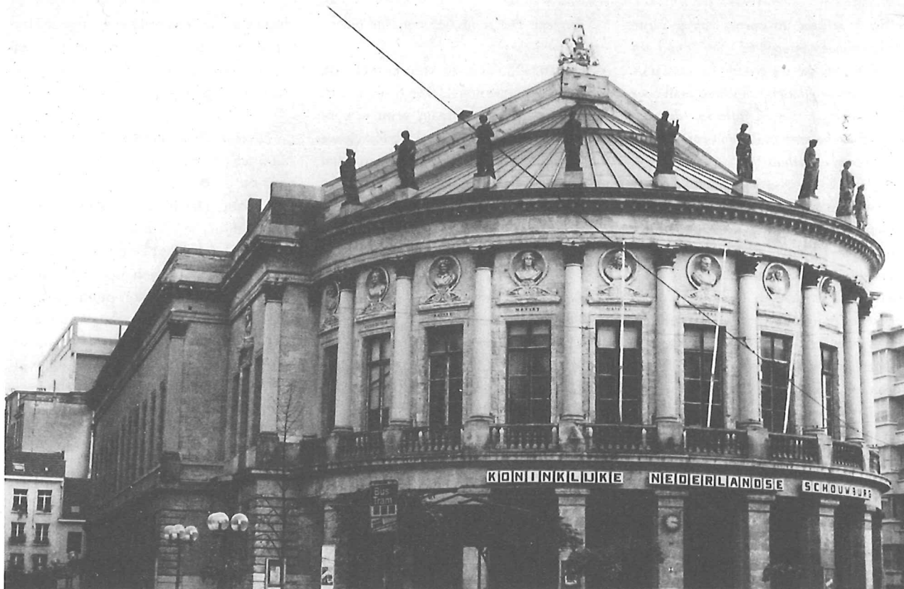
De Bourla, voor de restauratie
